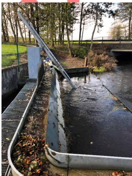
Figur 2 Vandindtag med ristebygværk
