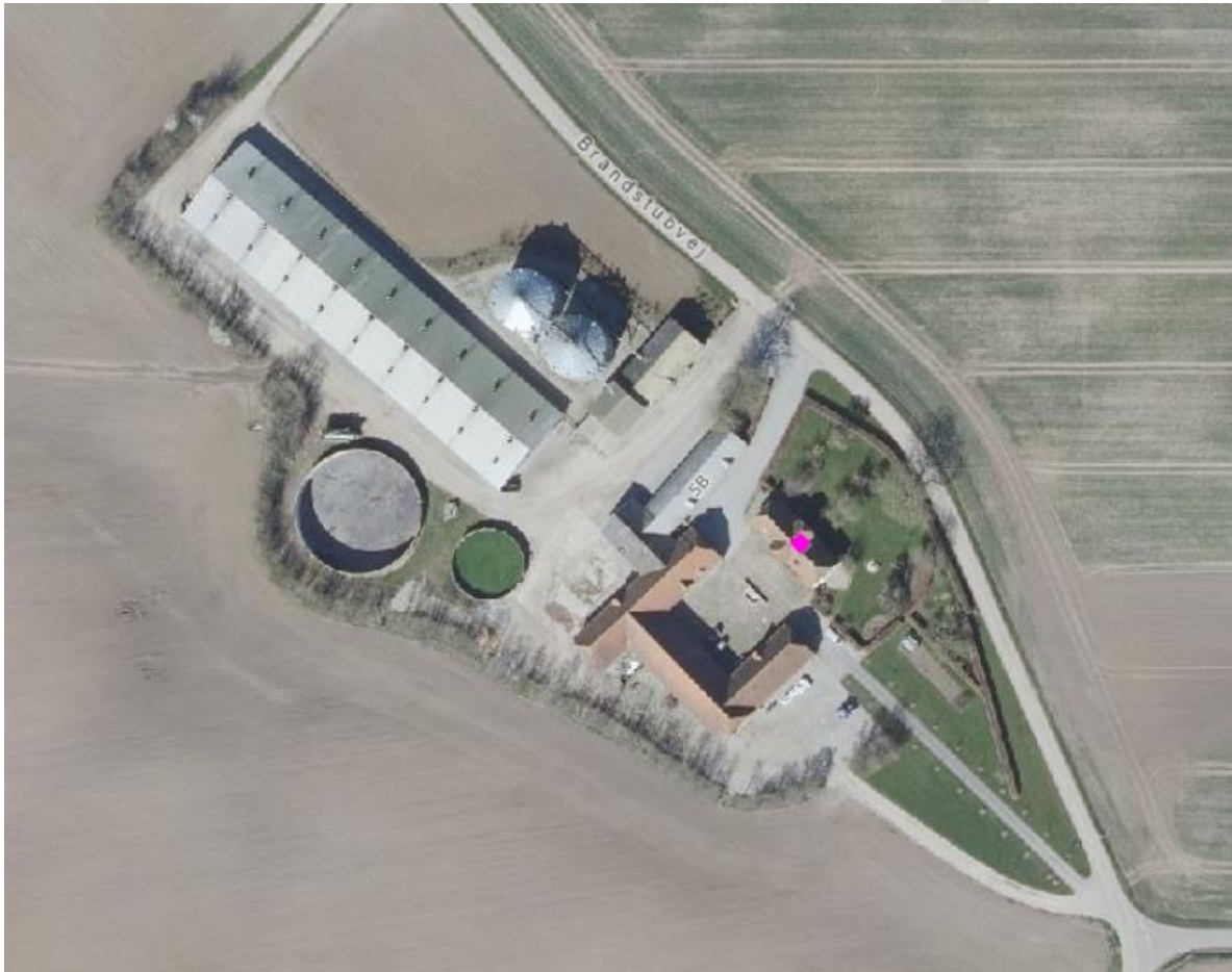
Figur 1: Ørnsvigvej 5, 7130 Juelsminde. Copyright: Hedensted Kommune
