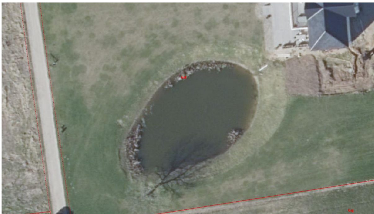
Figur 1 Luftfoto fra foråret 2025. Indløb til regnvandsbassinet er synligt i det nordøstlige hjørne som et hvidt rør. Kronekanten som overgang mellem den lysegrønne skråning og mørkegrønne flade i terrænet.
