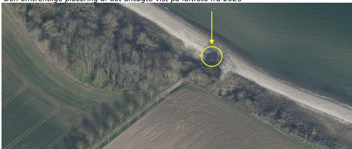
Placering af eksisterende badehus ses på skråfoto fra 2023
