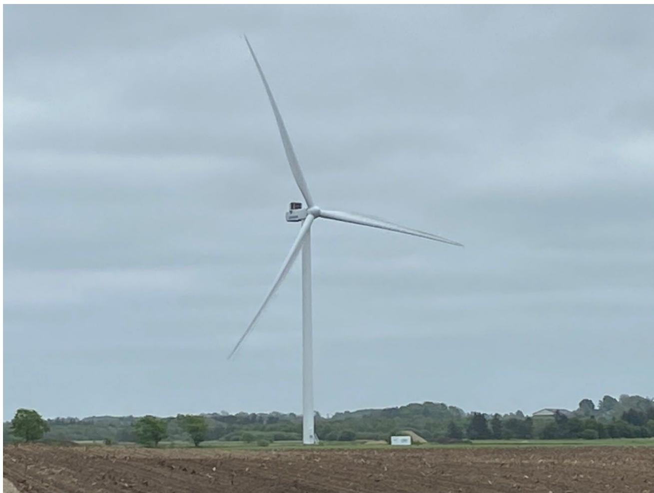
Figur 5-2. Vestas V136 vindmølle med en totalhøjde på 150 meter.
