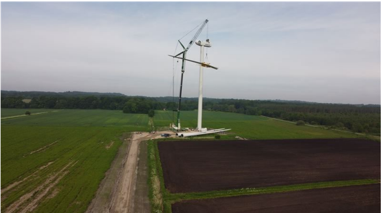
Figur 5-7. Arbejdsplads med kran under løft af vinge til en Vestas vindmølle.
