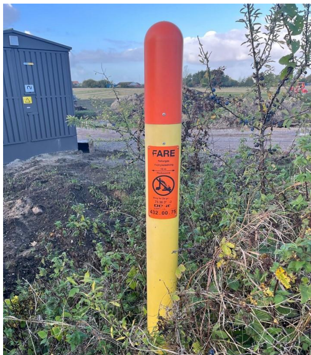
Figur 13 - Billede af mærkestander, der markerer gasledning
