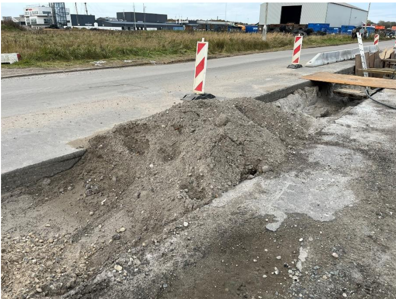
Figur 6 – viser ledningsgrav anlagt med begrænset arbejdsareal
