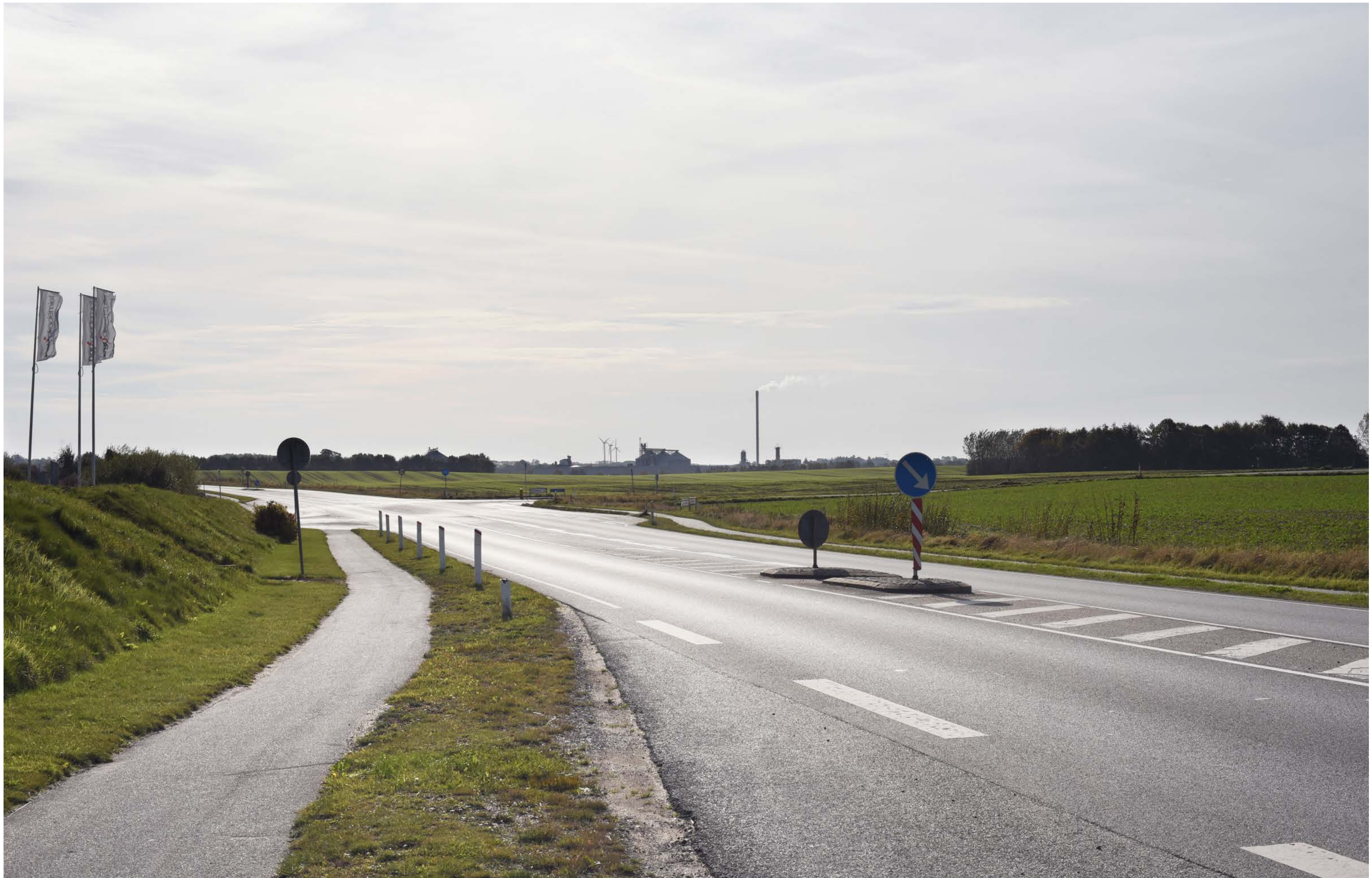
BJERREVEJ VED BGI AKADEMIET | FOTOSTANDPUNKT 22 | EKSISTERENDE FORHOLD
