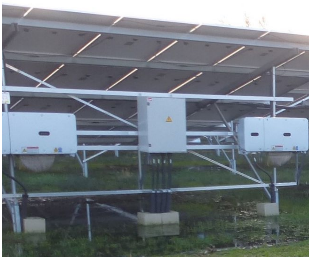
Figur 5-7 Inverterne er små bokse, der placeres under solpanelerne.
