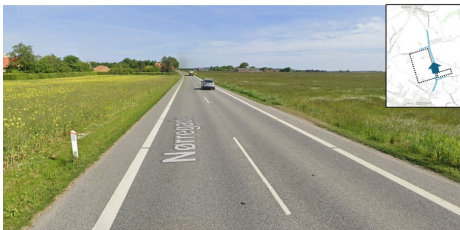
Figur 6-8 Nørregade set mod nord (Google Streetview, 2023)
