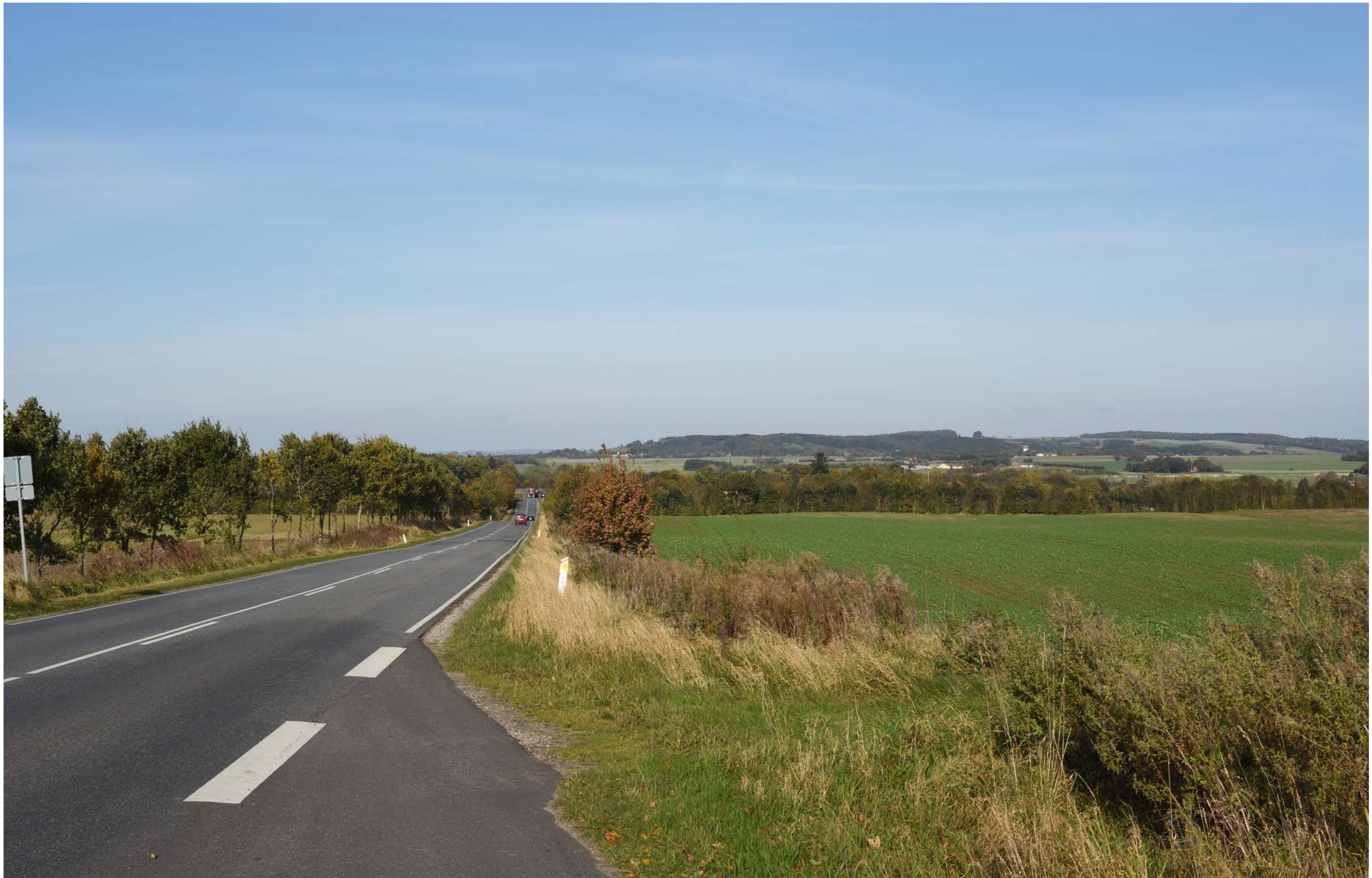
BRÅSKOVVEJ, NORD FOR HORNUM | FOTOSTANDPUNKT 28 | EKSISTERENDE FORHOLD
