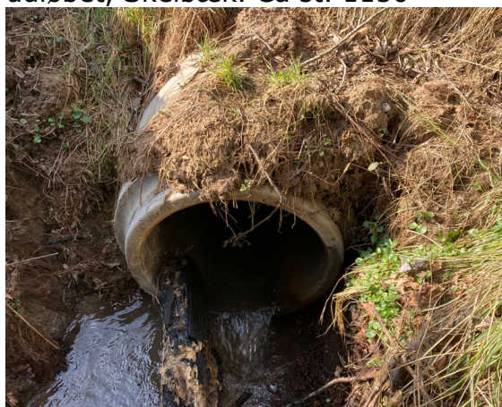
Rørlagt overkørsel med fald ud af røret. Spærring for faunaens fri passage. Ca. st.2280
