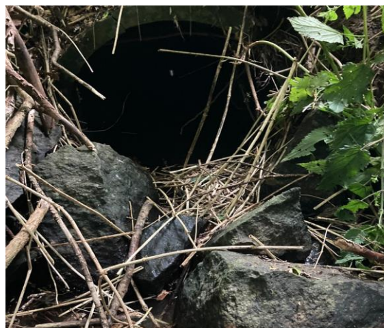
Rørlagt overkørsel med fald ud af udløbet, Skelbæk. Ca st. 1150
