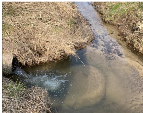
Udløbet af Skelbæk i Rårup Å, Her er et stort fald ud af røret, og derfor en faunaspærring. Ca. st. 2790
