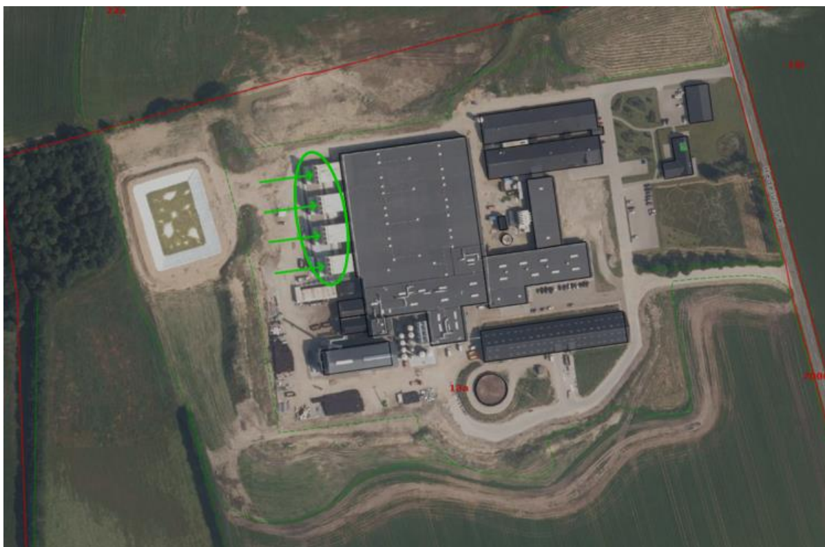
Gønne pile peger på de 4 afkast, som er søgt forhøjet med 6,5 meter – luftfoto fra 2024
