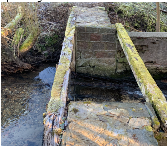
En del af bygværket i beton, der udgør spærringen
