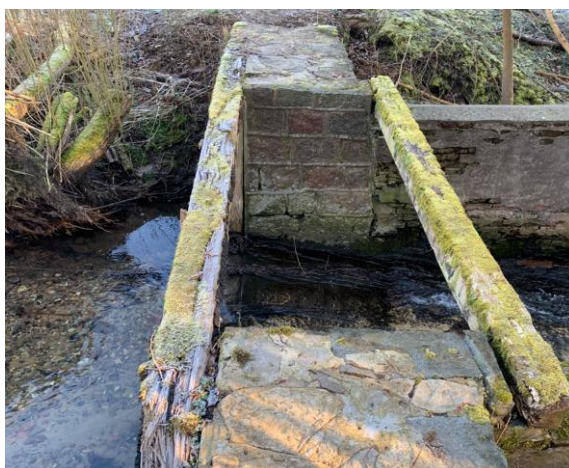
En del af bygværket i beton, der udgør spærringen
