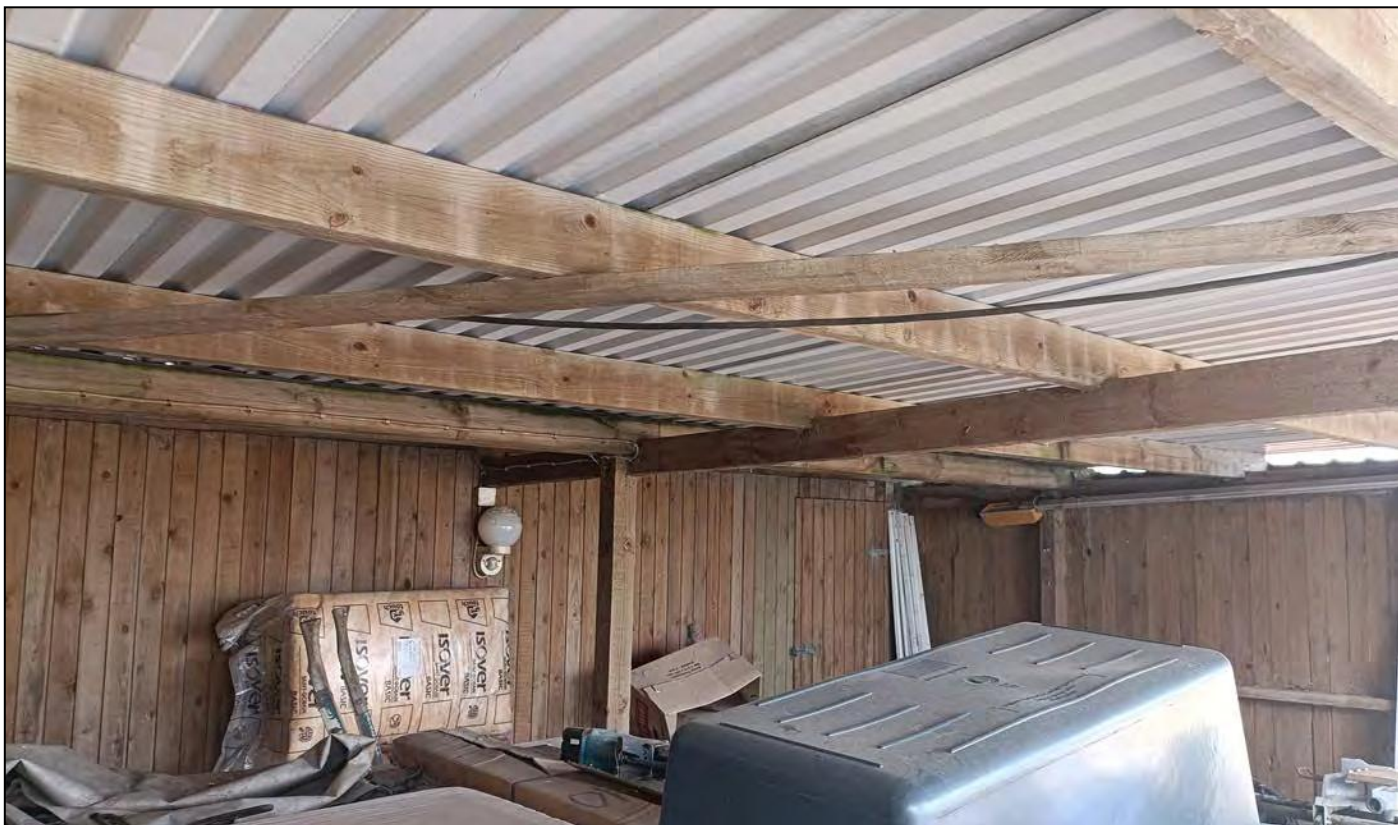
Foto 6. Åben carport på Hesselballevej 20.
