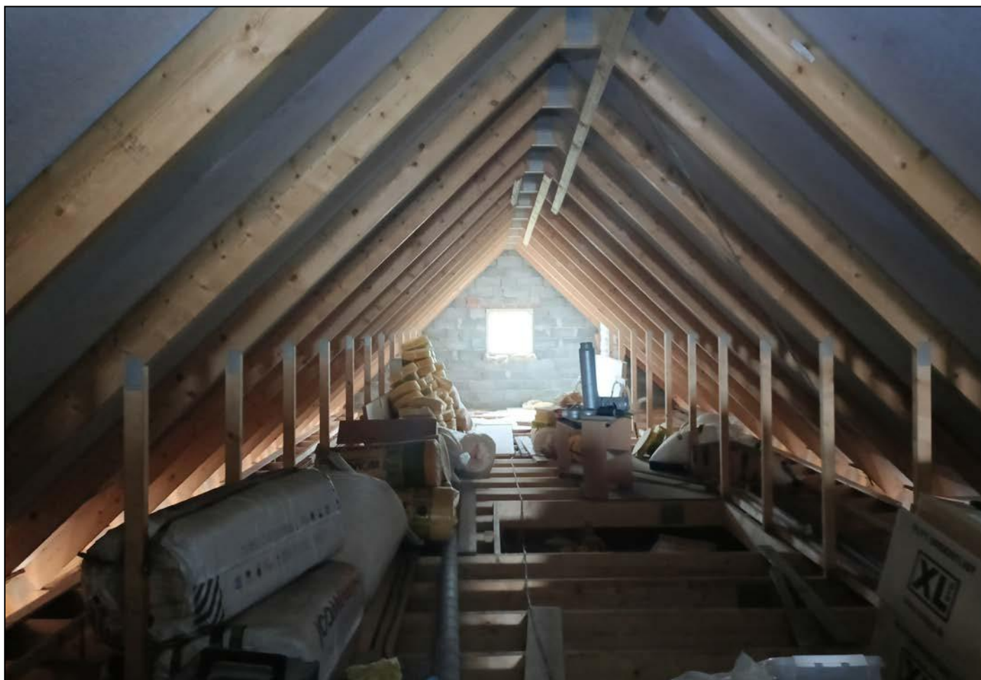
Foto 4. Åbent loftrum af hovedbygningen på Hesselballevej 20.
