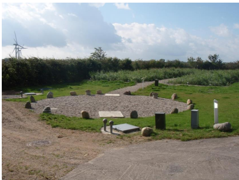
Billede af anlægget
