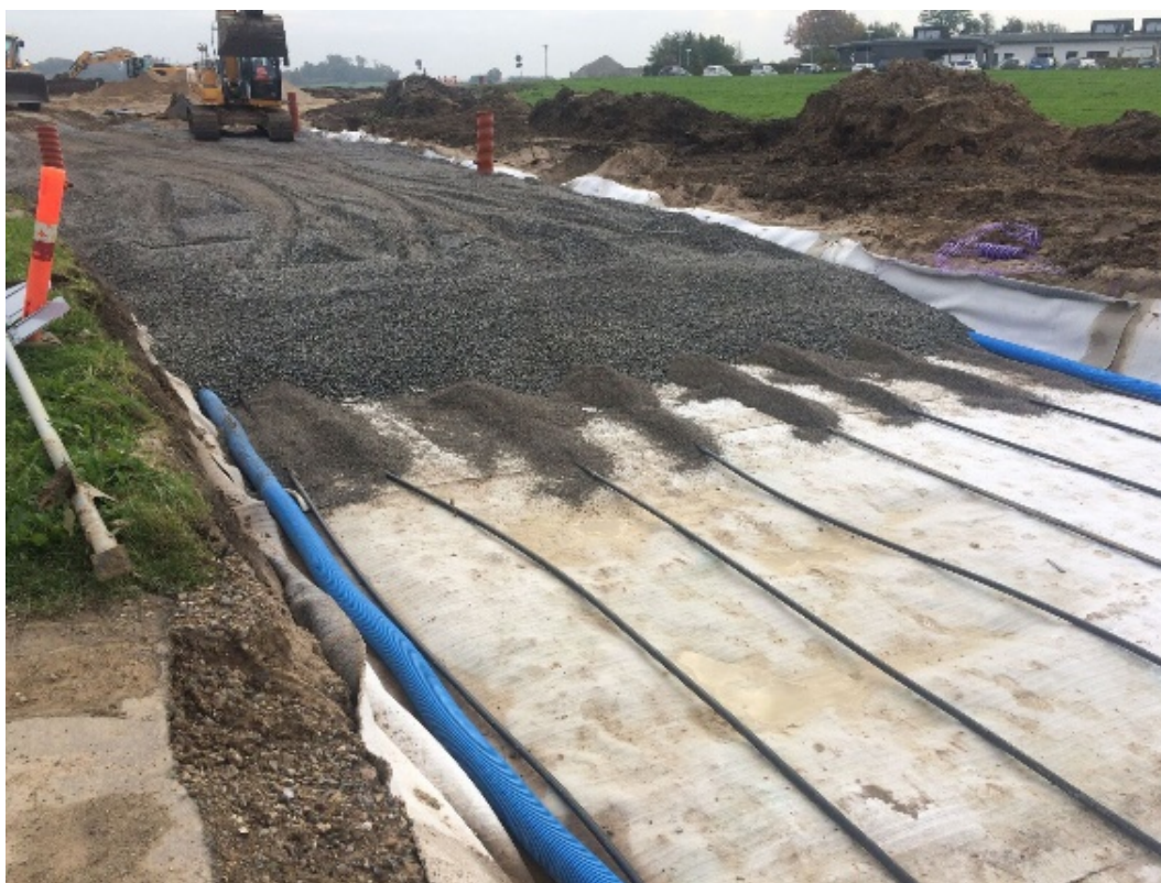
Figur 1: Billede af vej-kassen. Bentonitmåtten ses med hvidt, de nedre jordvarmeslanger ses nederst i billedet over bentonitmåtten, mens dræningssystemet ses med blått. Foto: Theis Raaschou Andersen
