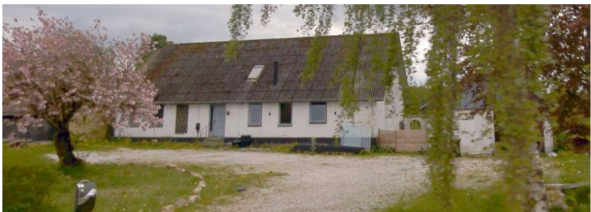
COWI gadefoto fra 2024 visende bygningen som ønskes indrettet med to lejligheder
