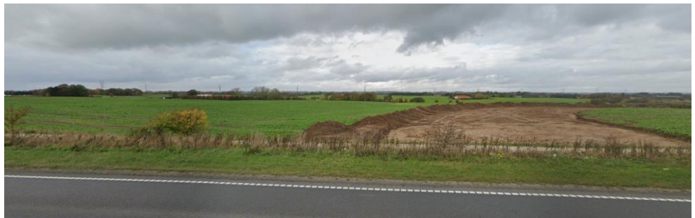
Planområdet nord for Vestvejen dvs. fra syd mod nord. Det ses at vejadgangen til lastbilkøberingspladsen er ved at blive lavet. (Google Street view).
