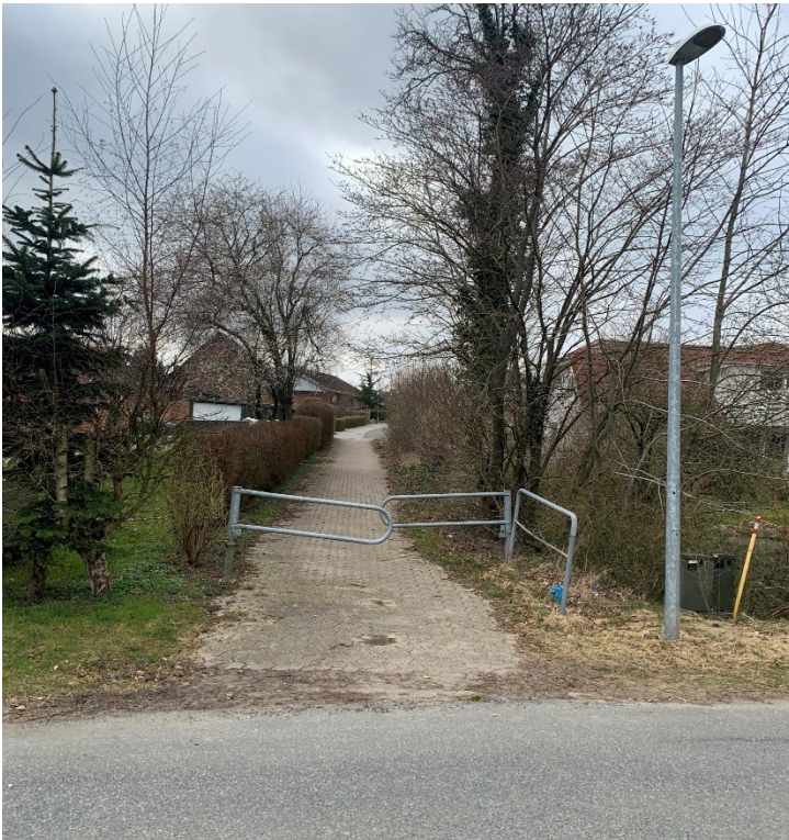
Figur 4. Stibom ved tilslutning til Kalhavevej. Tilslutningen er belyst, men der er ingen refleksafmærkning på bommene.
