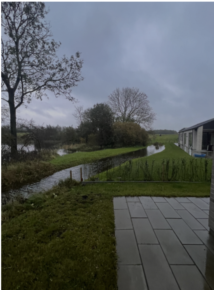
Figur 3 Til venstre ses den fredede sø. Grøften ved siden af, burde være tom, men er fyldt med overfladevand fra området. Når grøften svømmer over, vil vandet sive ned i den fredede sø, fordi der aldrig er blevet etableret en ordentlig vandafledning fra Remmerslund Skovby.
