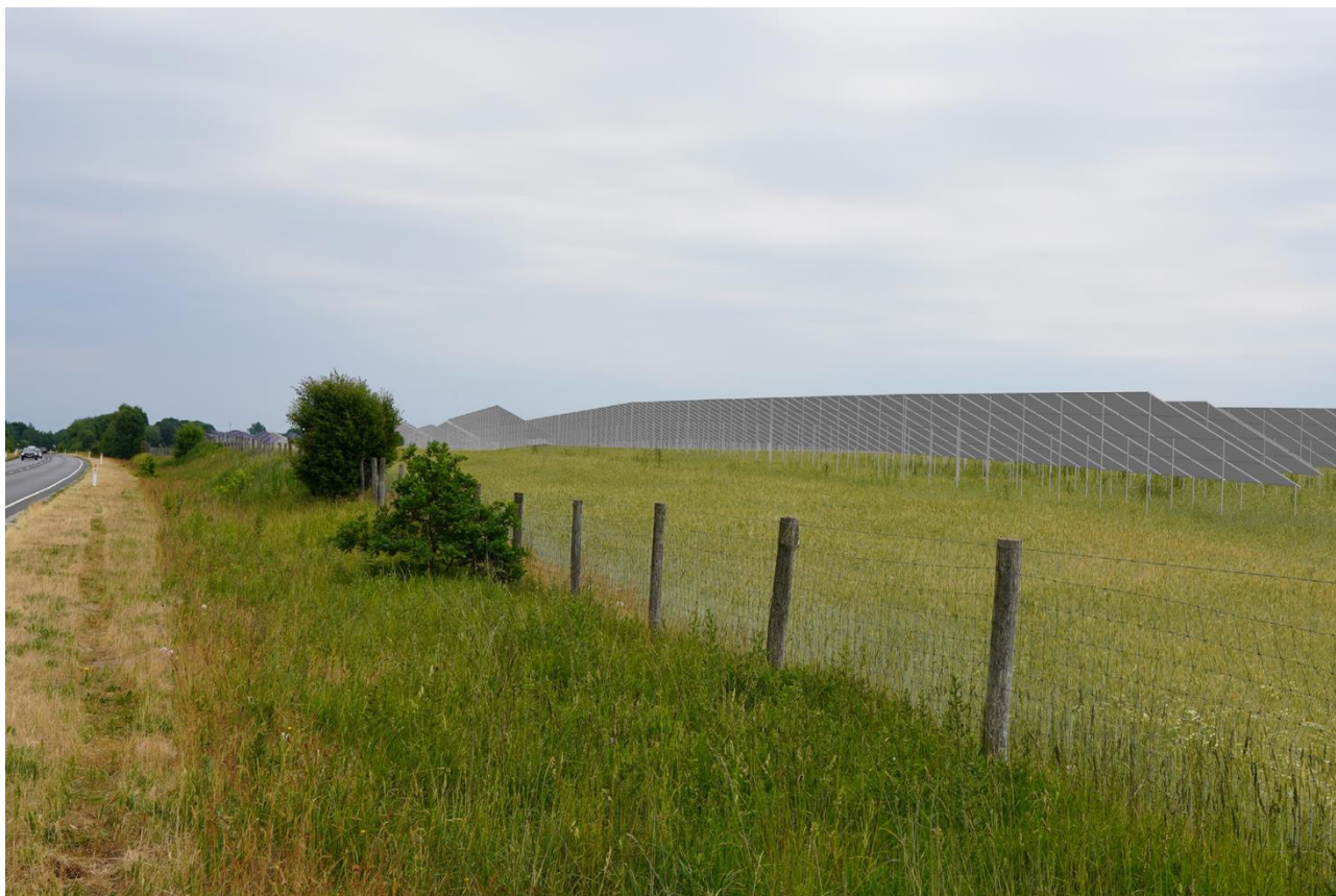
Fotostandpunkt 2: Visualisering af solcelleanlægget umiddelbart efter etablering set fra Vestvejen med kig i østlig retning.
