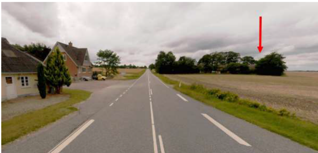
Mastens placering (rød pil) på foto fra COWI set fra Korningvej fra øst mod vest
