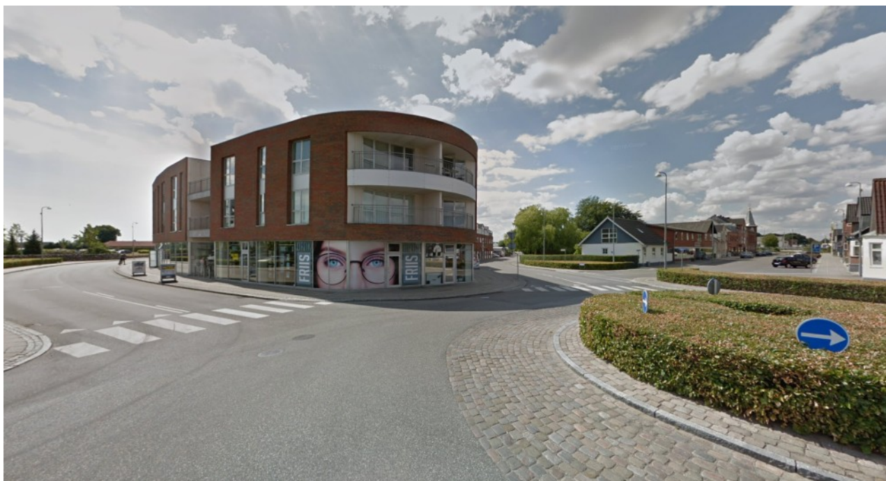
Lokalplanområdets eksisterende bebyggelse, set fra nord i rundkørslen ved Haralds Plads og Østerbrogade. Her ses de tre etager i det eksisterende byggeri, hvor nederste etage med sine store vinduer er indrettet til forskellige typer af butikker, kontor-, service- og erhvervsformål. Google Streetview 2023.
