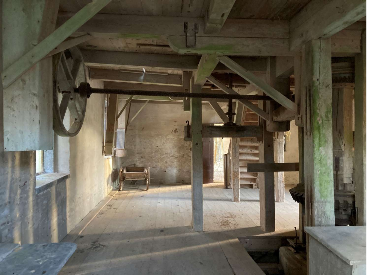
Trækstang med remtræk på den aksel som forbinder møllen med den vestlige længe, som ønskes nedrevet.
