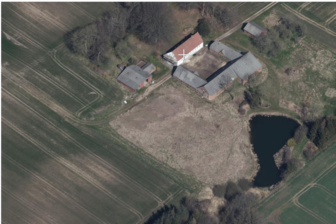
Skråfoto af eksisterende bygninger
