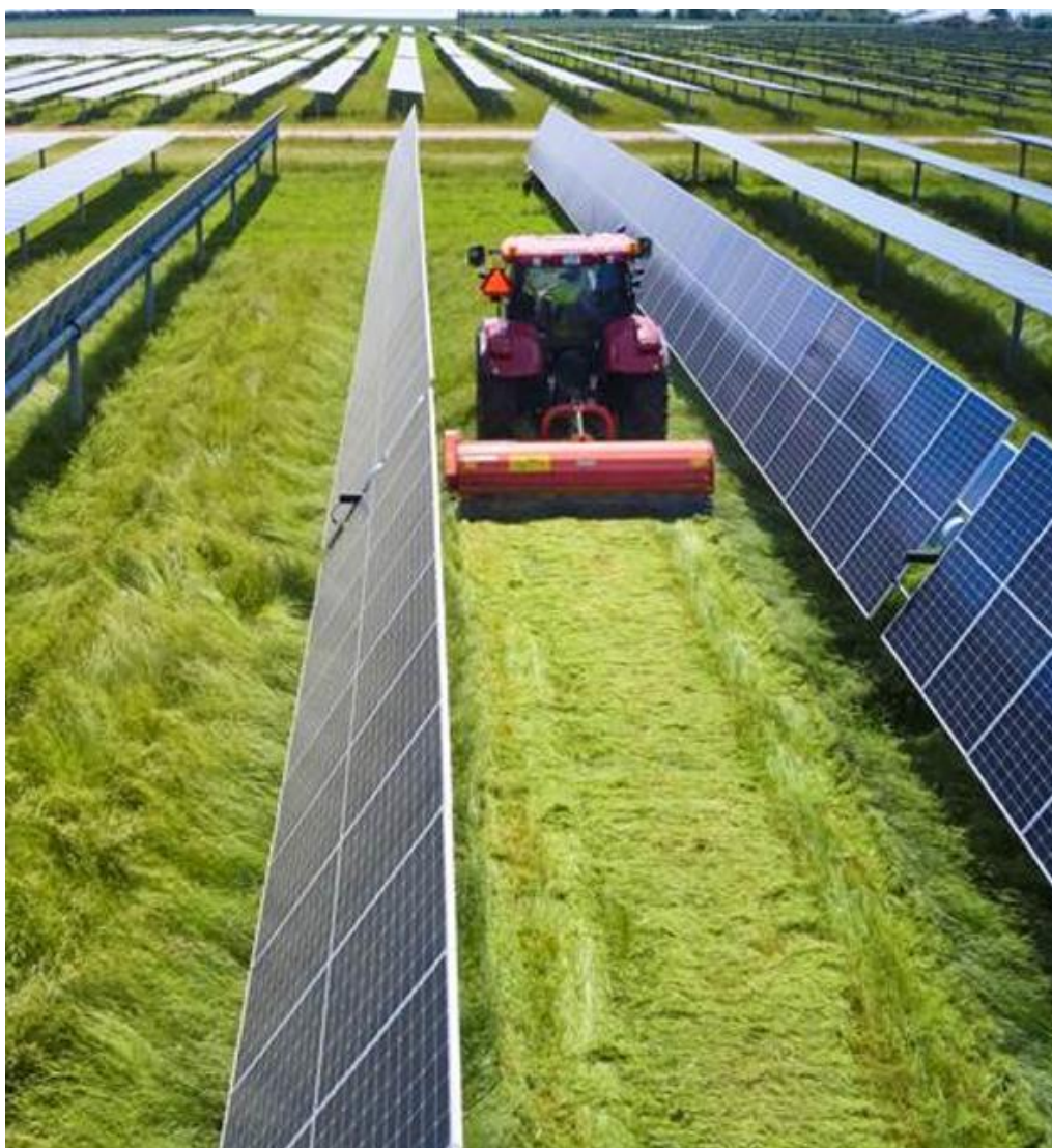
Figur 3-3 Eksempel på solcellepaneler på trackerstativer.
