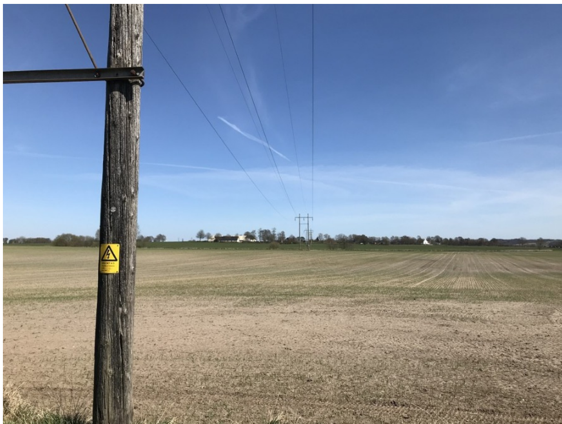
Højspændingsmaster og -ledning i lokalplanområdet
