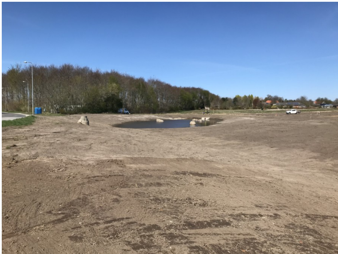
Billede fra etape 1, hvor et opstuvningsareal er anlagt. Opstuvningsarealerne tilplantes med hjemmehørende arter af græs og urter med lavt plejeniveau.
