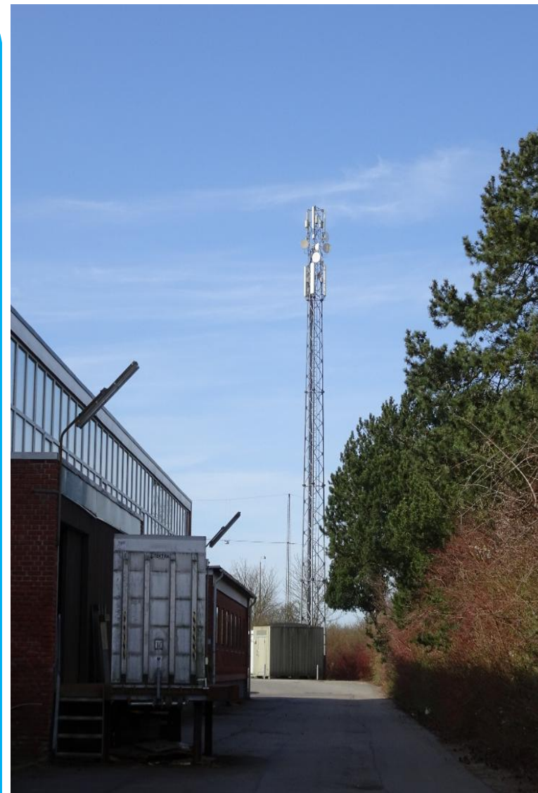
KK1 + CC2 Selvbærende gittermaster placeret i bebygget område, med lav risiko for skade, f.eks. som illustreret ved parkeringsplads i industriområde, eller ved siden af en gård.
