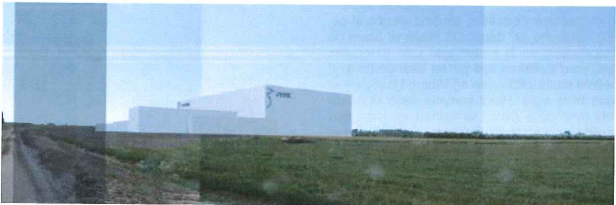
Eksempel på visualisering af en lagerbygning, hvor de foranliggende bygninger har en højde på henholdsvis 12 og 18 m og med et bagved liggende højlager på 45 m's højde
