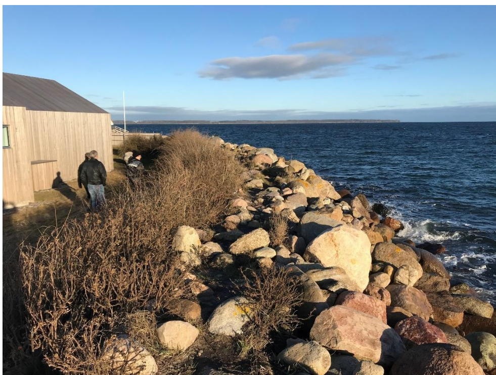
Figur 2-6 Dæksten fra stenskråningen i vandet for foden af skråningen. Disse sten er sandsynligvis faldet ned i forbindelse med en storm. Stenskråningen er her noget stejlere end de øvrige steder.
