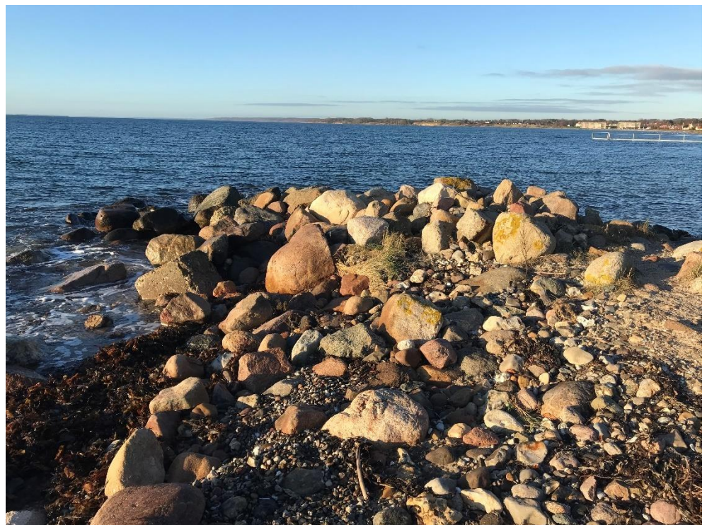
Figur 2-15 Umiddelbart vest for spidsen er etableret en kort lav stenhøfde. Denne holder delvist på sandet der transporteres langs kysten på dette sted.
