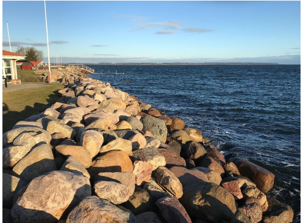
Figur 2-4 Eksisterende stenskråning ved Bjørnsknudevej, mod nord.
