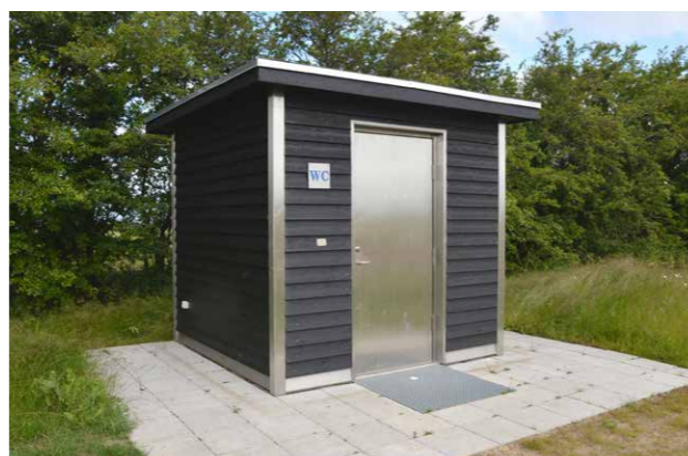
Handicappedtoilet med vand-, kloak- og el-tilslutning
