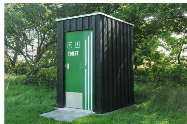
Toilet uden el og vand, men med tank, Mossøbrå
