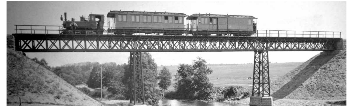
Højbroen i jerngitterkonstruktion fra 1899.
