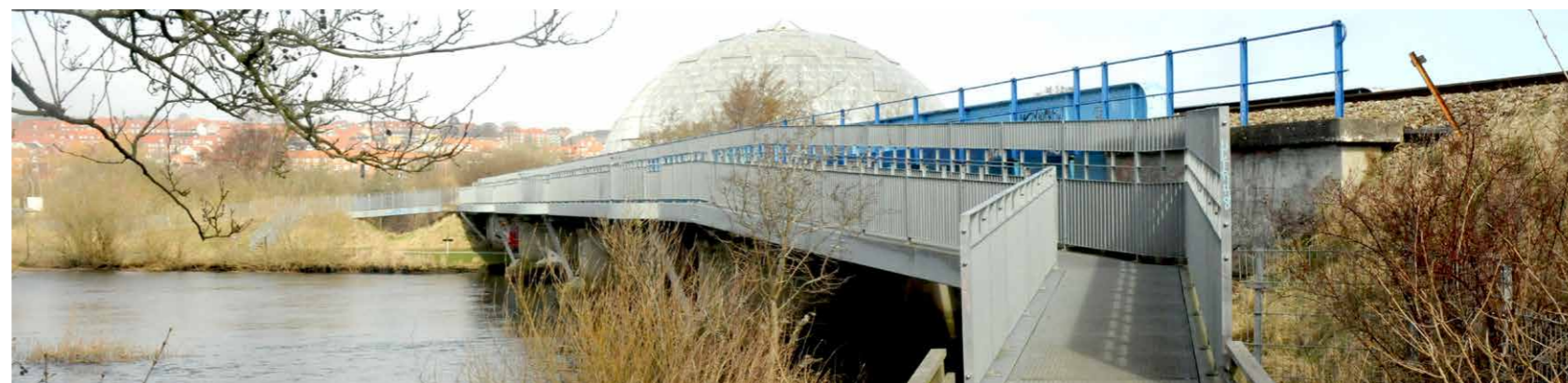
Stiforbindelse mellem Randers Regnskov og Vorup Enge over Gudenåen – etableret på siden af motorvejsbro.
