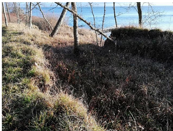
Foto 4. Lerskrænt er skredet ca. to m ned. (2020).
