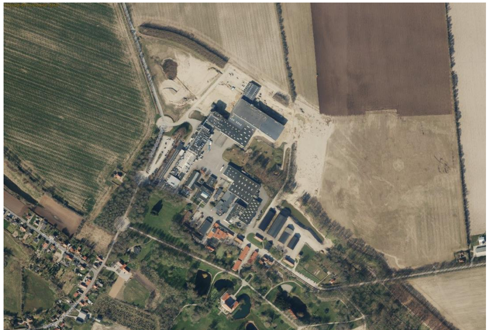
Figur 5.1: Luftfoto fra 2020, der viser de eksisterende forhold i planområdet.
