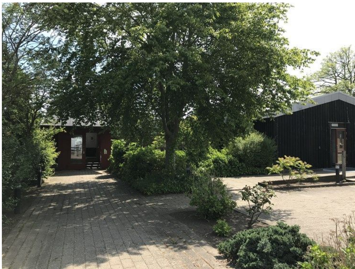
Eksisterende byggeri inden for lokalplanområdet.
