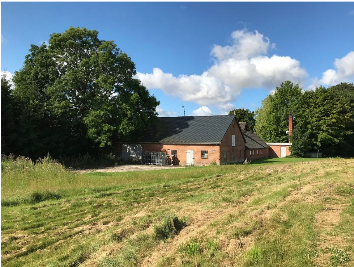
Ældre gårdbebyggelse inden for lokalplanområdet (Constantiavej 33).
