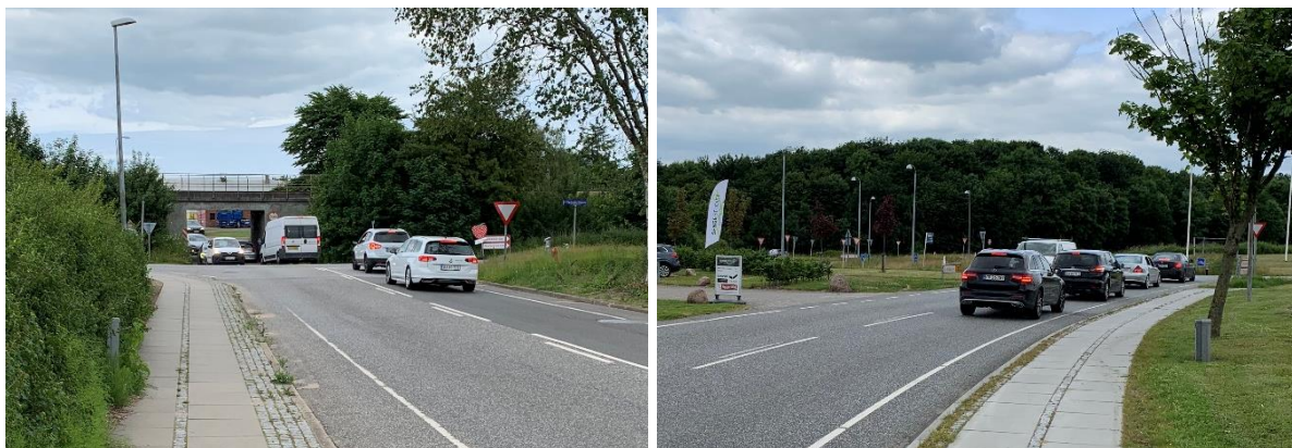
Figur 3 – Begrænset fremkommelighed på Overholmvej ved underføringen under jernbanen og i det prioriterede kryds ved Vejlevej.
