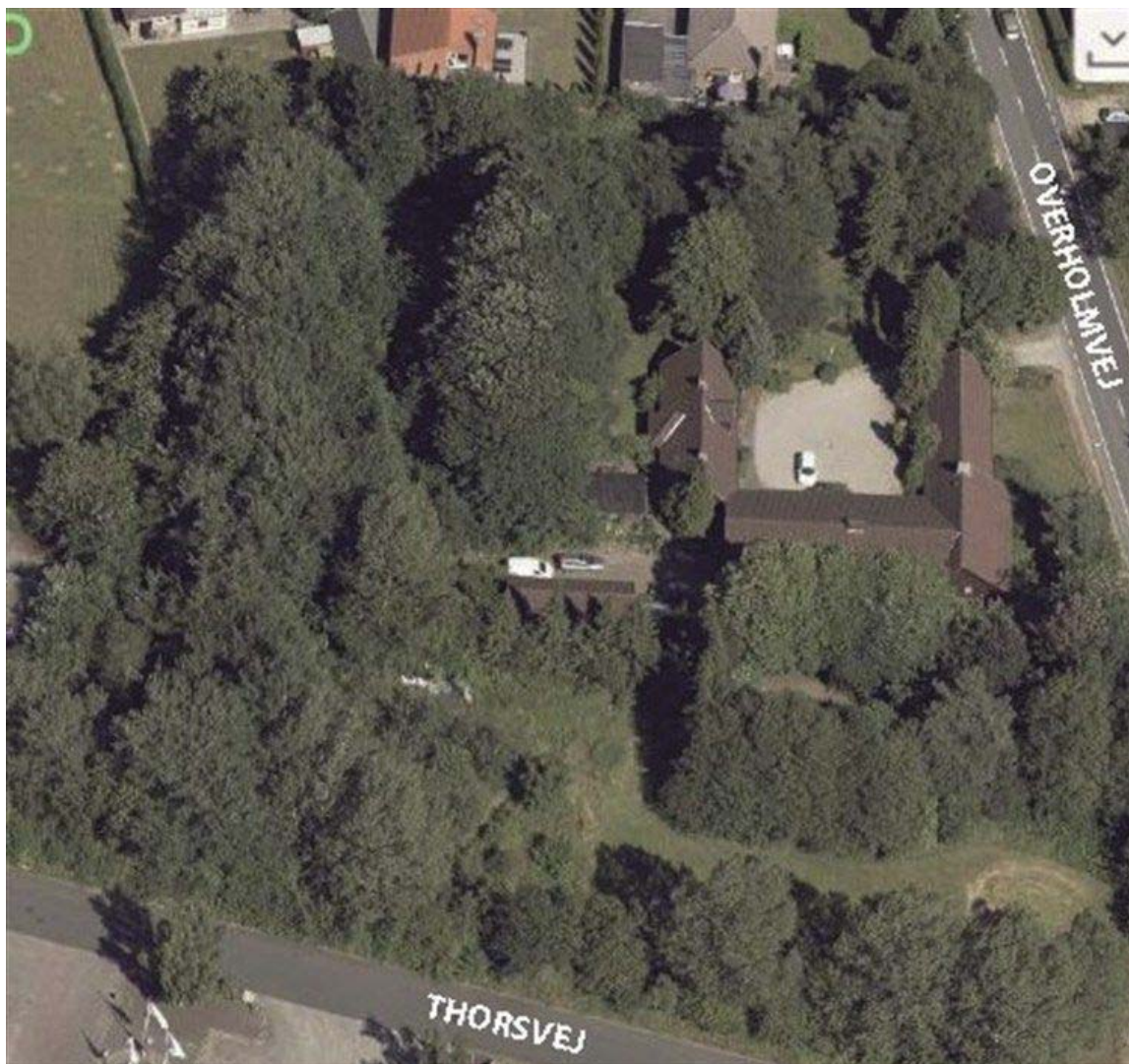
Skråfoto (optaget fra vest mod øst) af lokalplanområdet (SDFE, skråfotos fra Kortforsyningen, 02.09.2020). Lokalplanområdet indeholder en ældre gårdbebyggelse samt en del beplantning.
