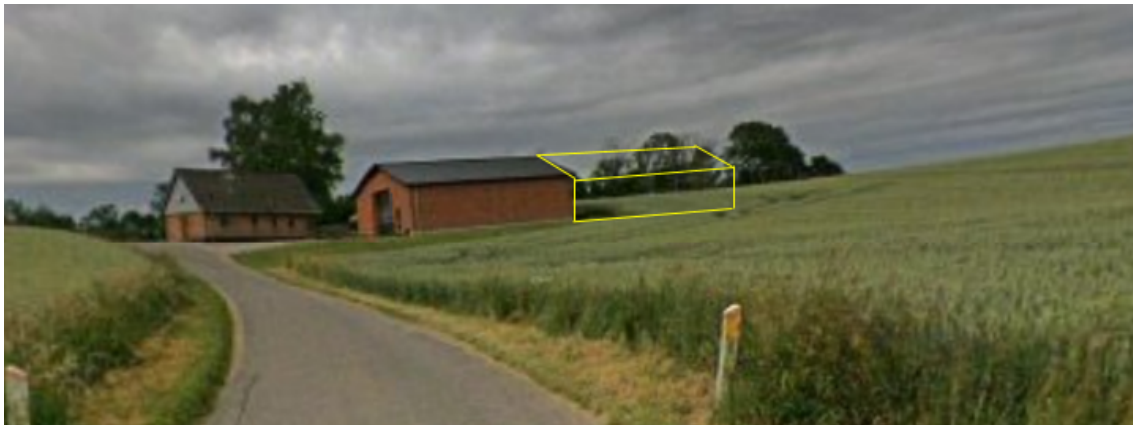
COWI Gedefoto af ejendommen, med nuværende bygninger, set fra Grundvej retning nord mod syd – gule streger illustrer omfanget af tilbygningen.
