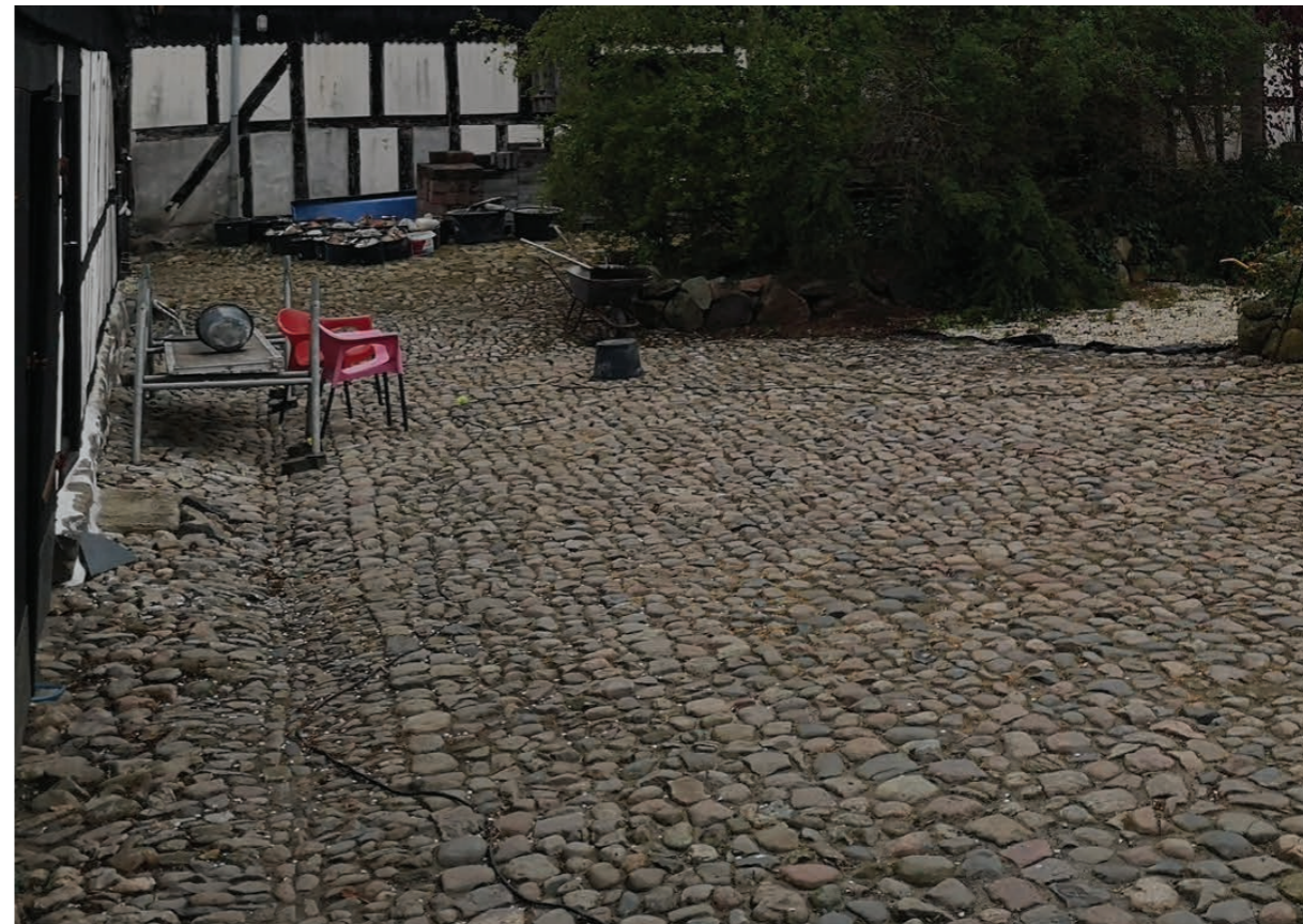
bindingsværk og pigstensbelægning
