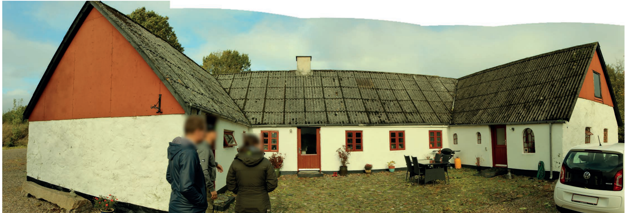
3 længet gård med høj rejsning - af gamle fotos ses bygningen også at fremstå i bindingsværk.
