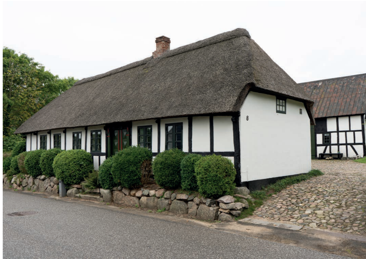
bindingsværk og pigstensbelægning
