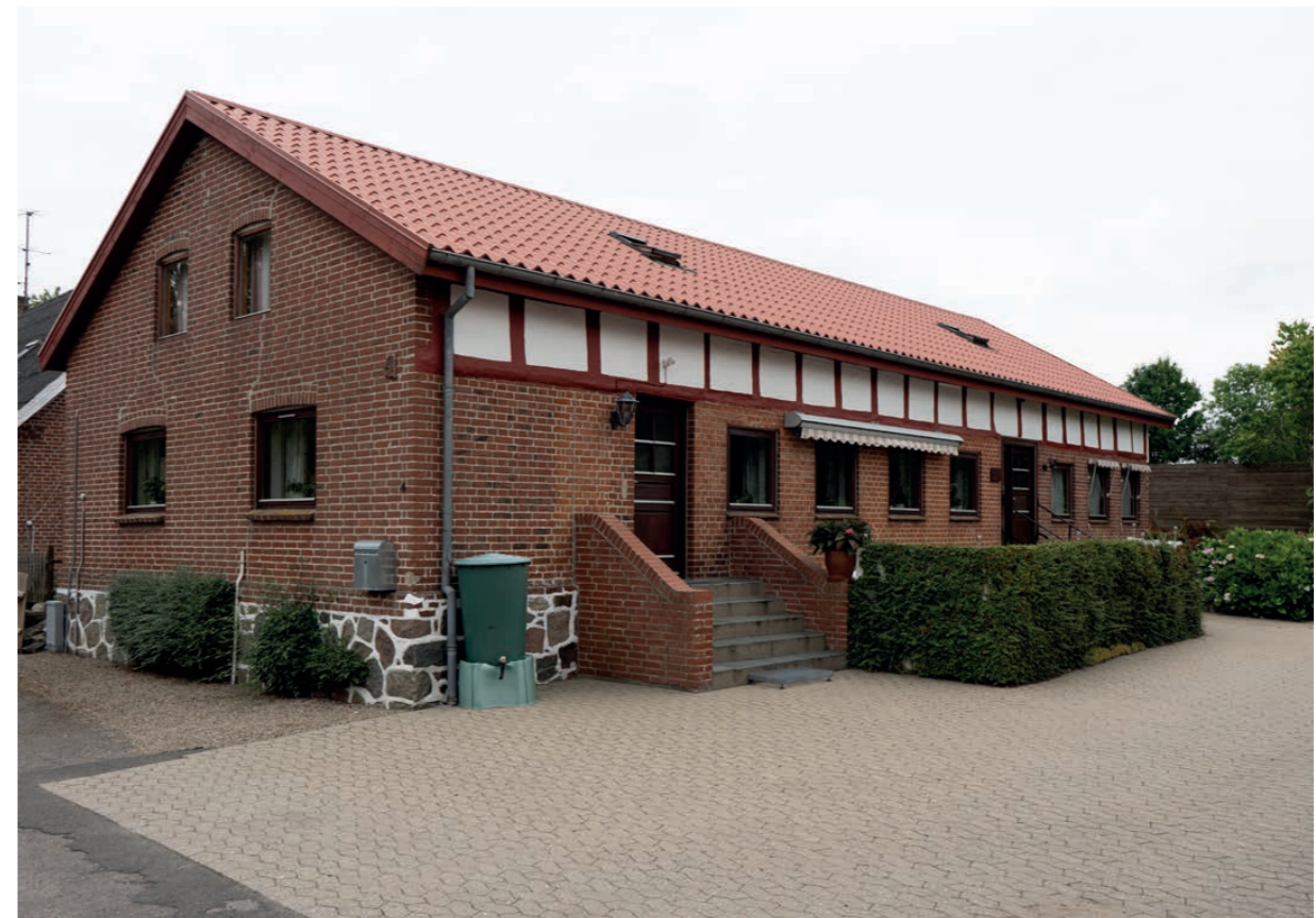
murværk med elementer af bindingsværk og kampesten
