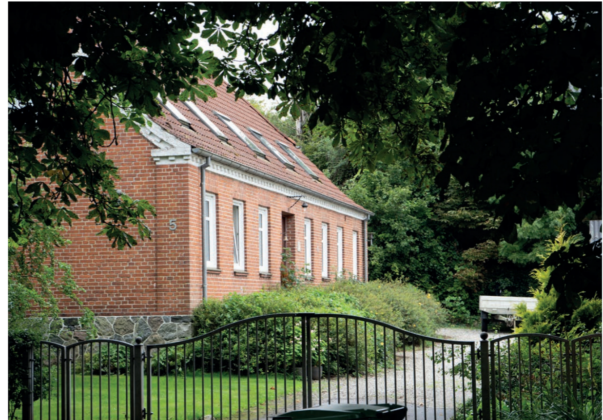
Ornamenteret oppudset murværk med høj rejsning - står på kampesten
