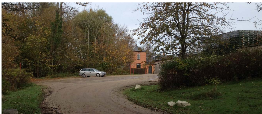
Billede 8: Eksisterende parkeringsplads P1 mod sydvest
