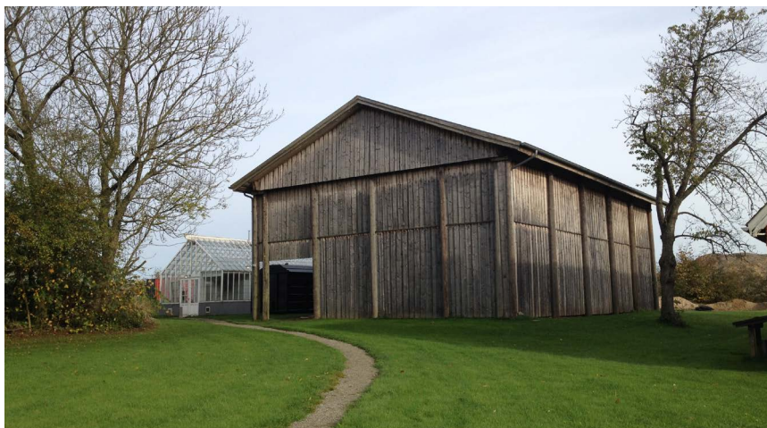
Billede 1: Den store bygning i træ benyttes som flislager
