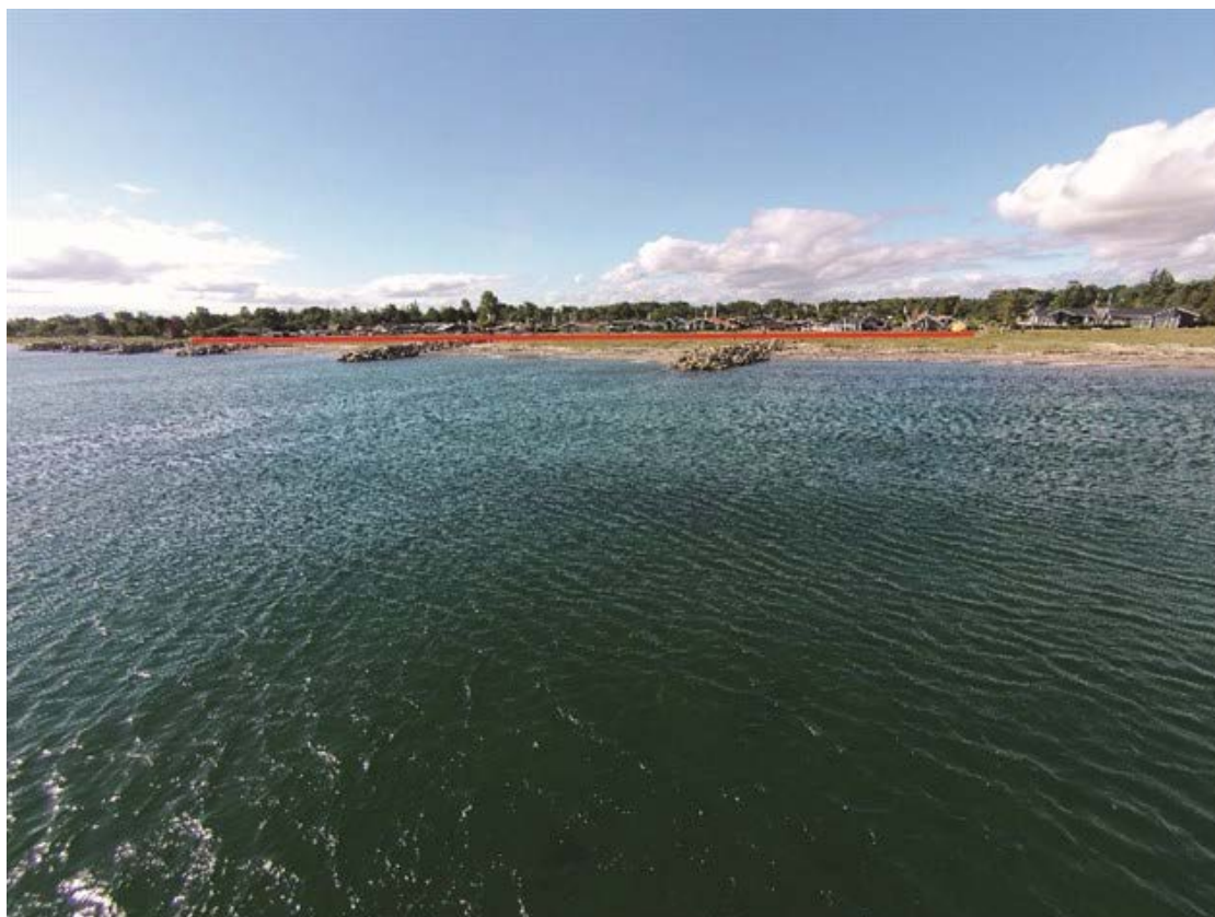
De to ovenstående billeder viser lokalplanområdet set fra vandet. Bebyggelsen er ens i højde og omfang.
