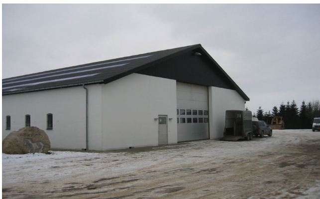
Eksisterende stald og ridehal i lokalplanområdet
