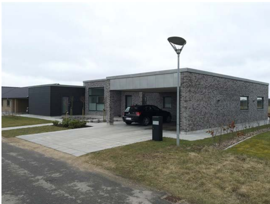
Bolig på Mårvej udført i tegl, med flad tag og carport der er bygget sammen med boligen
