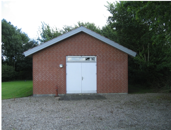
Figur 1: Solkær Vandværk. Foto fra tilsyn i 2010.
