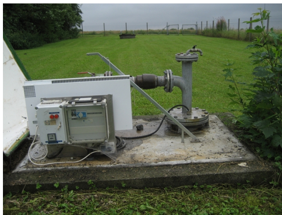
Figur 2: Til venstre: Indvindingsboring DGU nr. 116.1250 i forgrunden af foto samt DGU nr. 116.993 i baggrunden. Til højre: Kurve med indvindingsmængde (til 2015).
