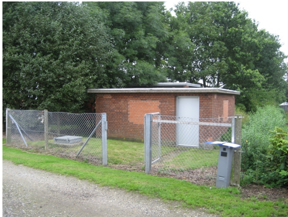
Figur 1: Kragelund Vandværk. Foto fra tilsyn i 2010.
