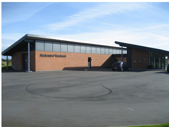
Figur 1: Hedensted Vandværk. Foto fra tilsyn i 2010.
