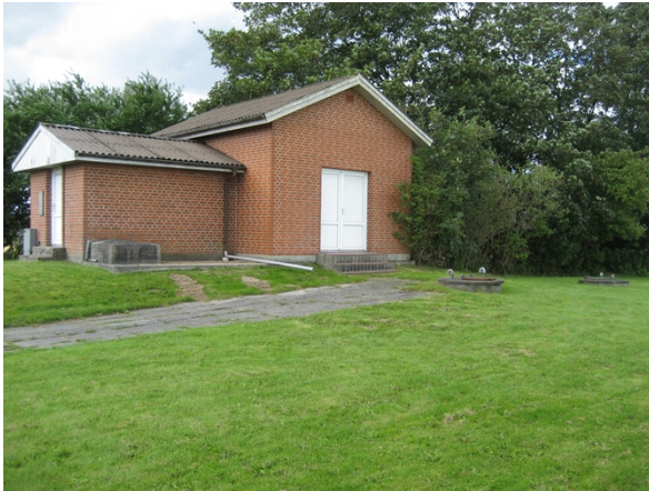
Figur 1: Båstrup-Gl. Sole Vandværk. Foto fra tilsyn i 2010.
