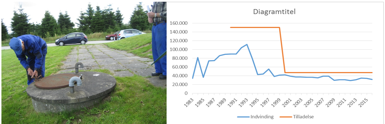
Figur 2: Indvindingsboring DGU nr. 116.850 samt kurve med indvindingsmængde (til 2016). Foto fra tilsyn i 2010.
