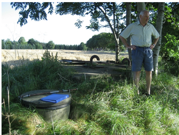
Figur 1: Båstrup Vandværk. Foto fra tilsyn i 2010.
