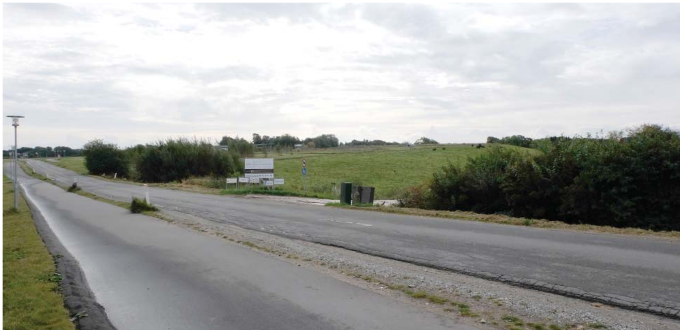
Fra Dalbyvej v. Myntevej - eksisterende forhold (position 2)
