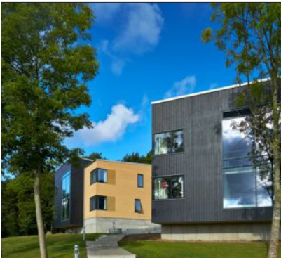
Foto visende eksisterende elevboliger
