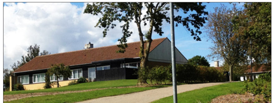
Foto visende lærer - og forstanderbolig Materiale og farvevalg som danner grundlag for arkitekturen i området
