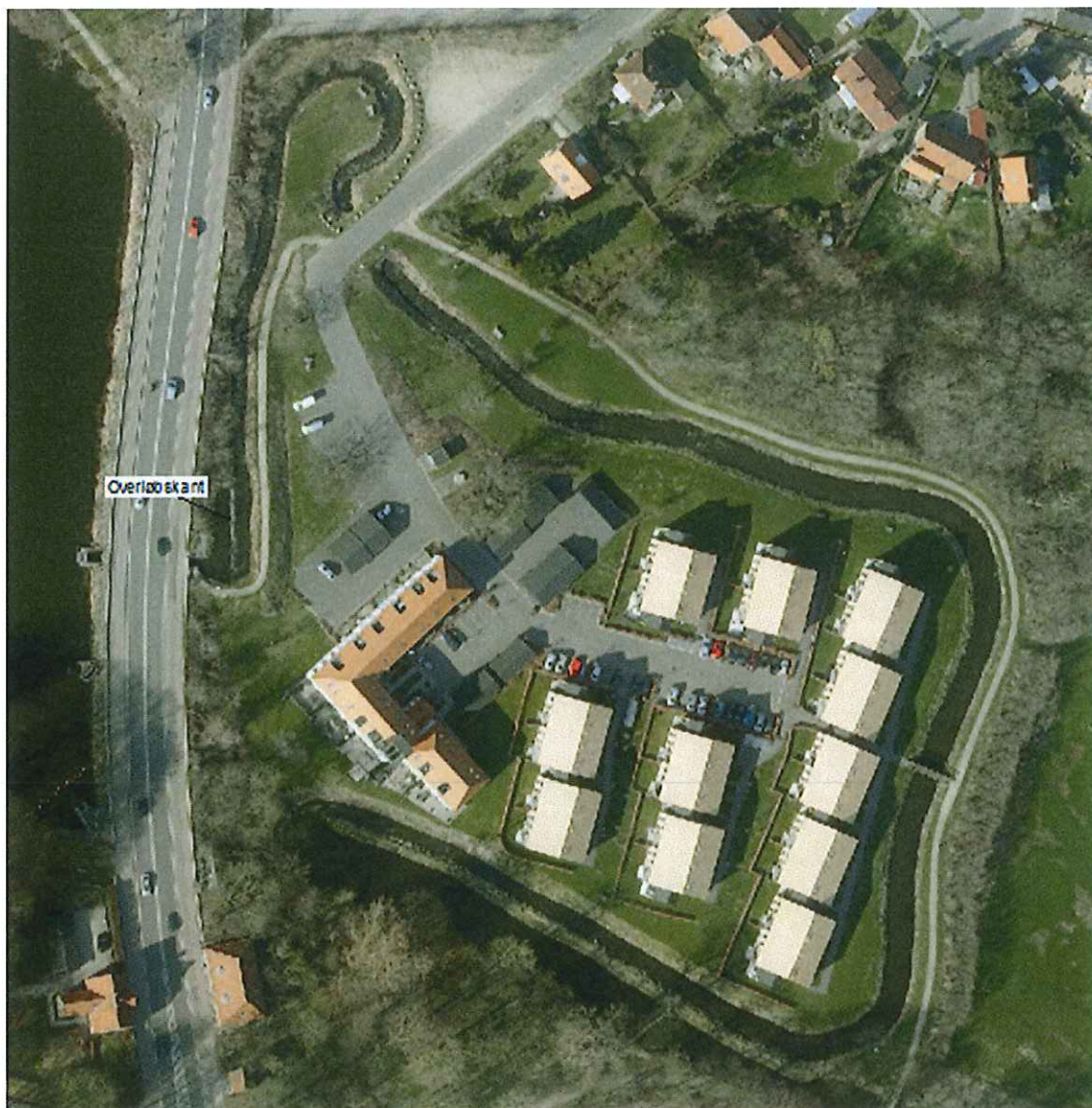
Omløbsstryget ved Bygholm Sø.
